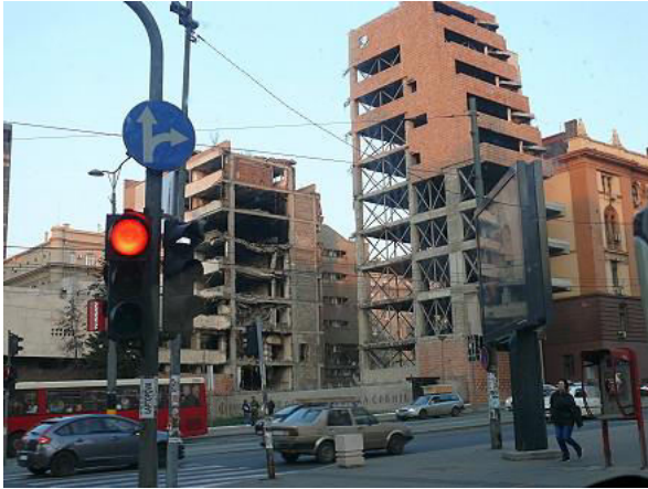
Belgrad, Gebäude in der Kneza Milosa, das im März 1999 von NATO-Bomben zerstört wurde und das auch nach 20 Jahren noch als mahnende Wunde erhalten ist
