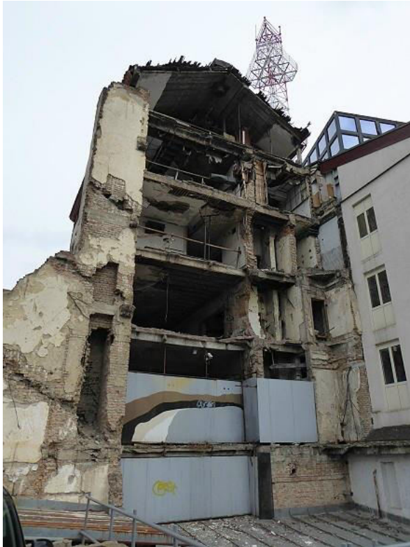
Gebäude der Serbischen Radio- und Fernsehanstalt (RTS), das im März 1999 von NATO-Bomben zerstört wurde und das auch nach 20 Jahren noch als mahnende Wunde erhalten ist
