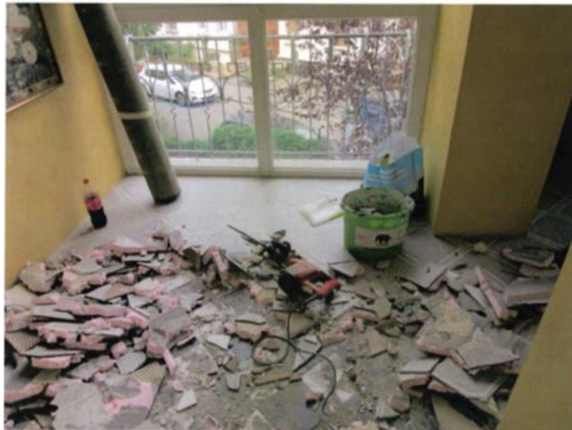
Renovationsarbeiten in der Küche, Fenster Richtung Schillerstrasse
